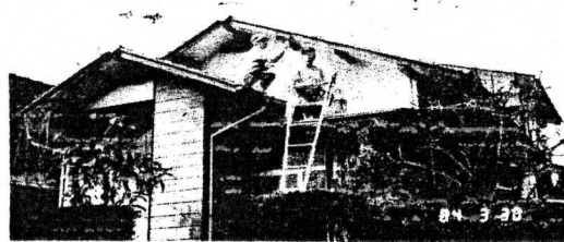
西初石 某宅 塗装工事
