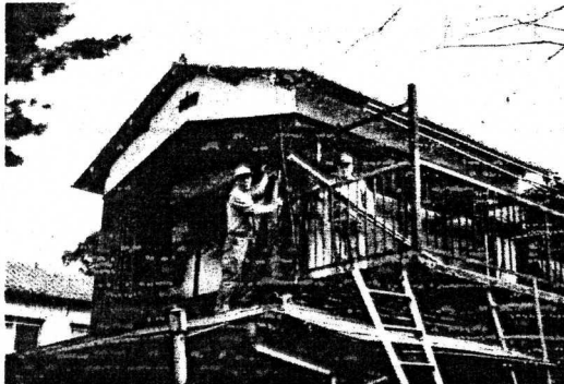
向小金 某宅 窓改良工事
